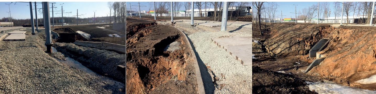
ивается для перехвата и отвода стекающих по склону ливневых и талых вод. Нагорная канава должна иметь поперечное сечение и продольный уклон заполнением не выше 25 сантиметров до верхней бровки. Её-то и не построили. Не учли проектировщики и огромную асфальтовую поверхность вокруг стадиона, с которой хлынула вода. В общем, такие ошибки в проектировании привели не только к параличу транспортной системы Кировского района города после сильных ливней, но и к большому материальному ущербу.
