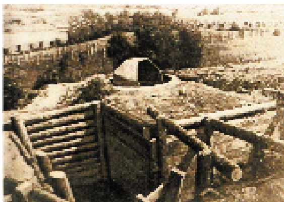
Железобетонный пулемётный дот с вращающимся бронеколпаком. Олонекое направление. Июнь 1944 год.
