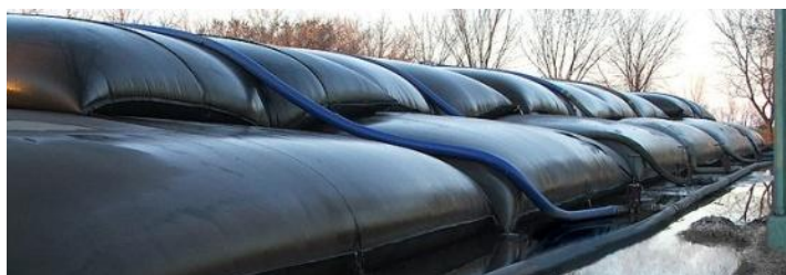
Общий вид зоны геоконтейнерного обезвоживания пастообразных отходов
